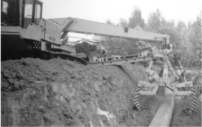
Рис. 1. Ущільнення ґрунту під магістральним трубопроводом машиною МП-М
